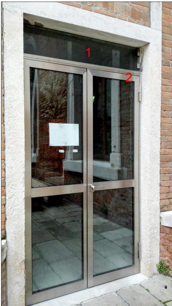
foto 3 sostituzione sopra luce e inserimento MAB porta corpo D
