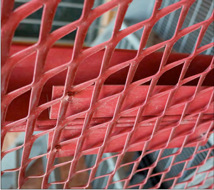
1 tipo di attacco della lamiera
