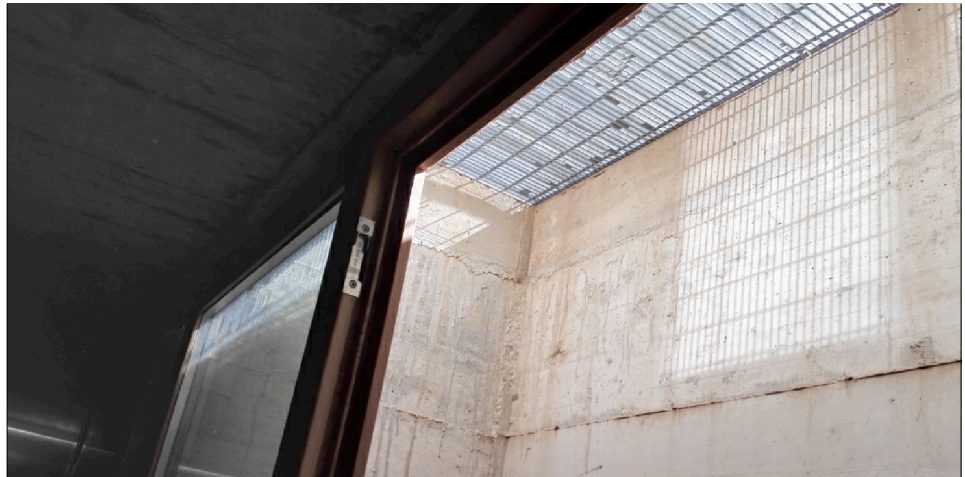
foto 2 griglia di aerazione corte delle galline quota -2.00
