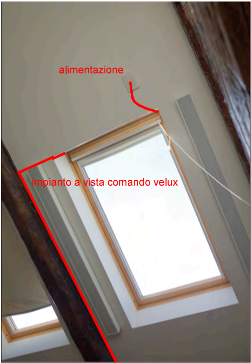
elettrificazione VELUX Corpo D
