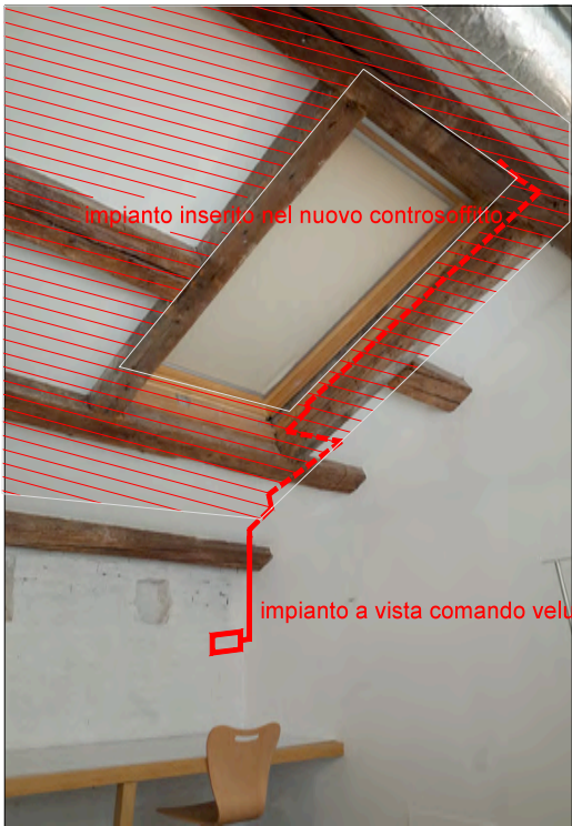
Elettrificazione VELUX Corpo F
