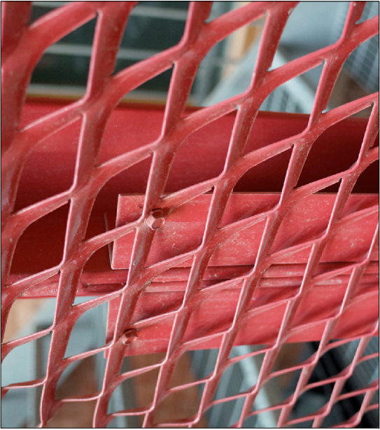
attacco lamiera a struttura pannello
