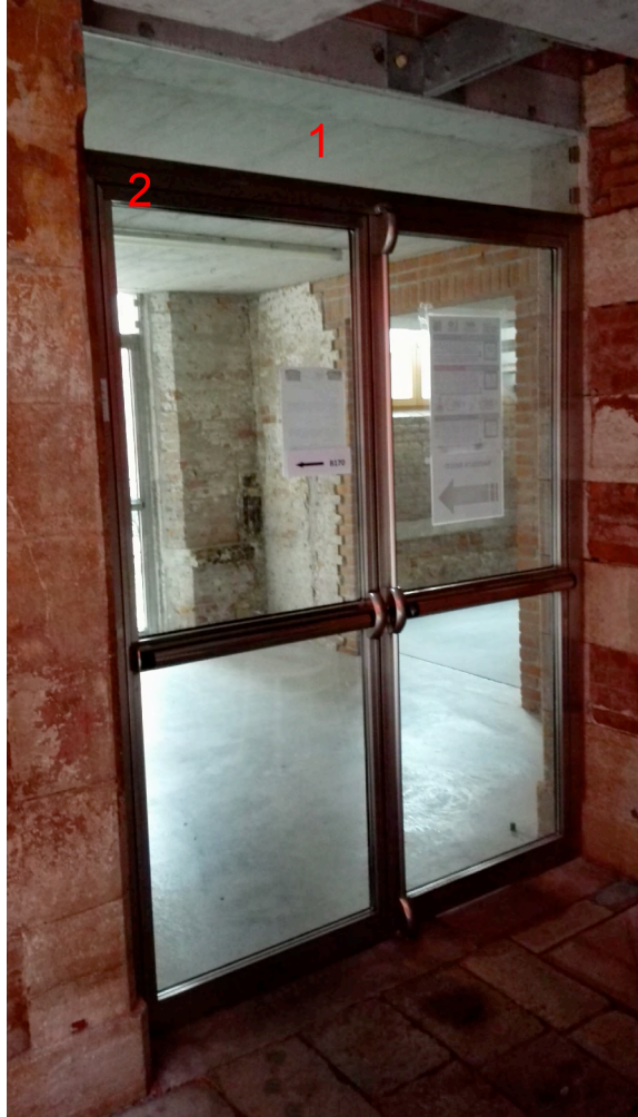
foto 2 sostituzione sopra luce e inserimento MAB porta corpo D
